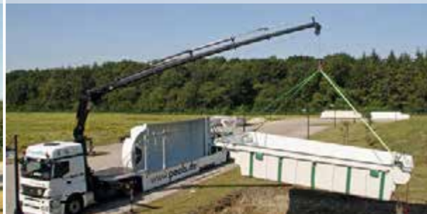
Einbau mit Betonhinterfüllung
