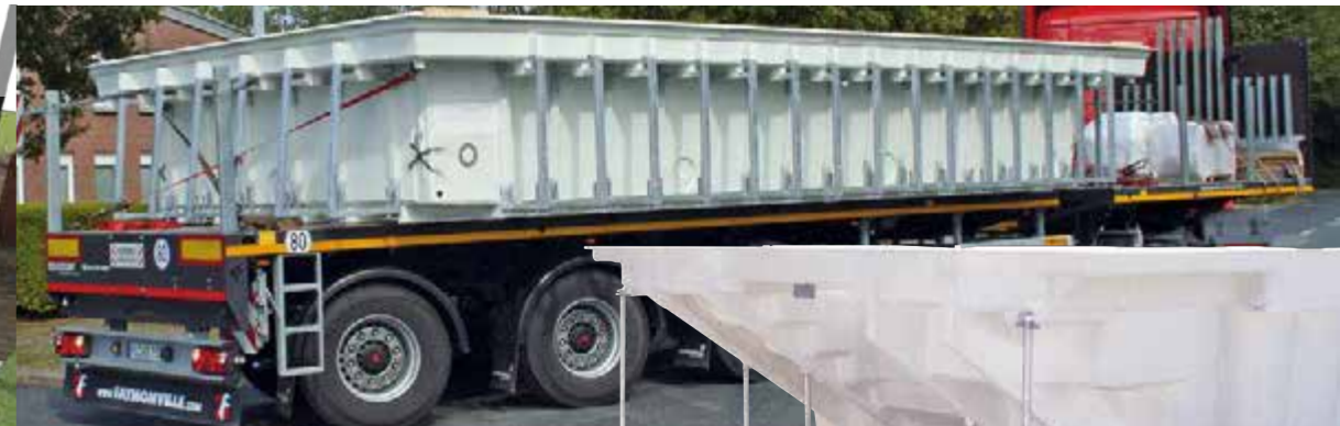
Einbau mit Wandverstreibungen
