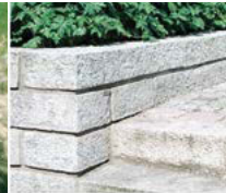
Granitblöcke als Stützmauer
