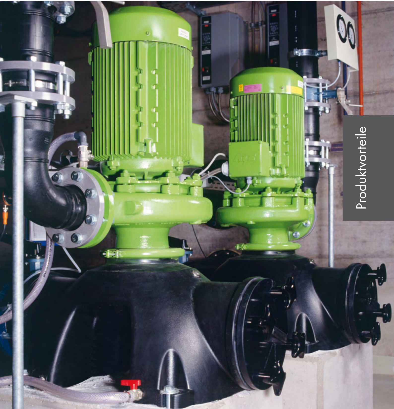
Abb.: Badewasserumwälzpumpe Optimo-F in kommunalem Schwimmbad
