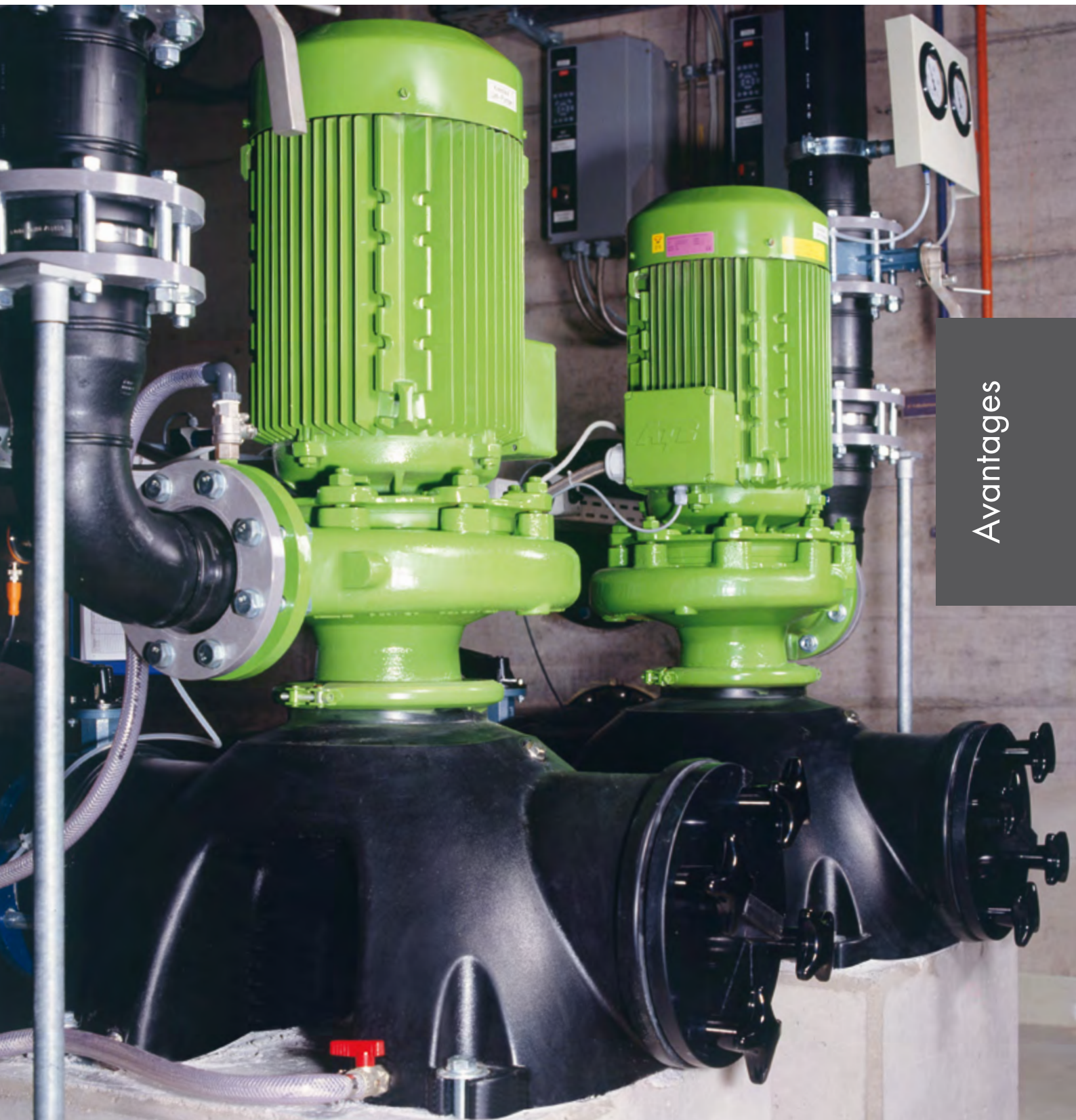
Pompes de circulation Optimo-F installées dans une piscine publique
